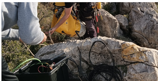
Momentos de preparación de los materiales (cámara video, placa solar, cables y dispositivos de conexión telefonía) para la instalación de las cámara video.
